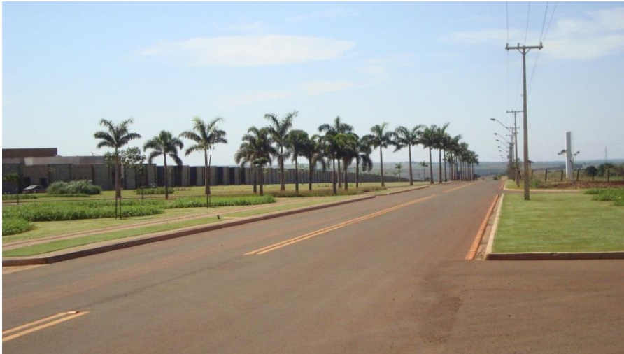
Figura 13. Fonte: MAISTRO, 2013. Infraestrutura na área do condomínio.
