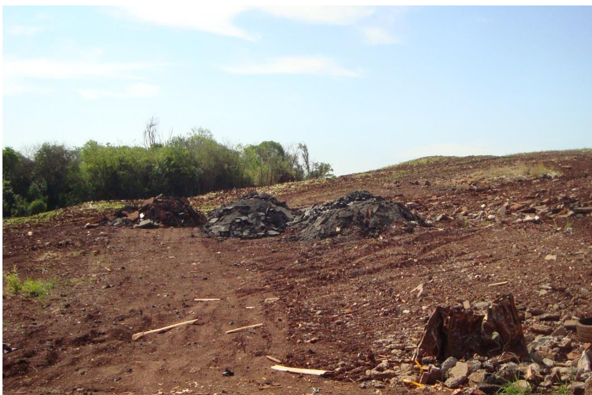
Figura 17. Fonte: MAISTRO, 2013. Entulho de construção.
